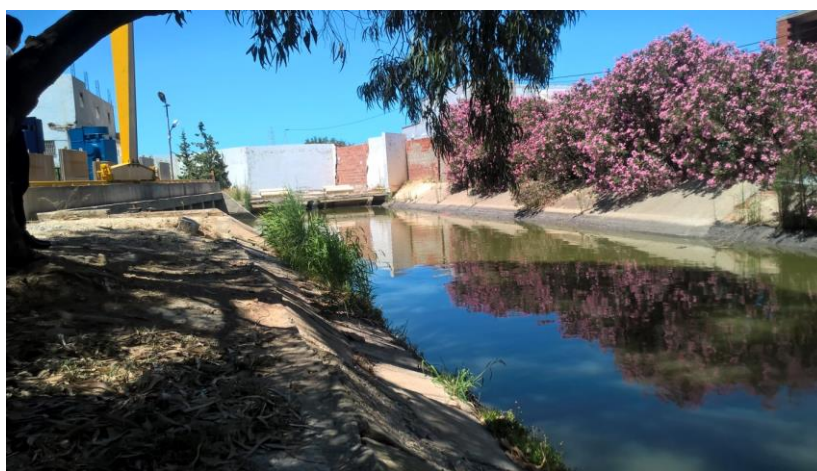
Figure 6: Canal de Khelidj et station de pompage du CRDA (à gauche)
