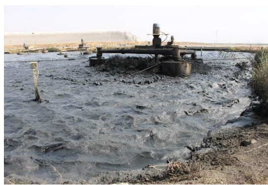
Figure 34 : agitateurs en fonctionnement – bassin biologique
