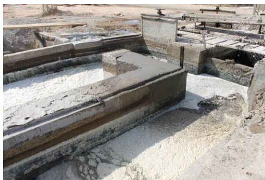
Figure 30 : Graisses dans le canal d'amenée
