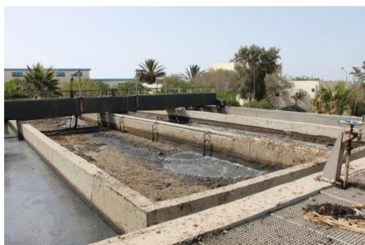
Figure 32 : dégraisseur/dessableur
