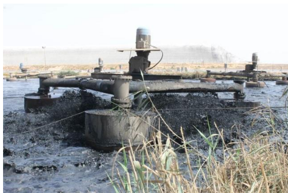
Figure 34 : agitateurs en fonctionnement – bassin biologique
