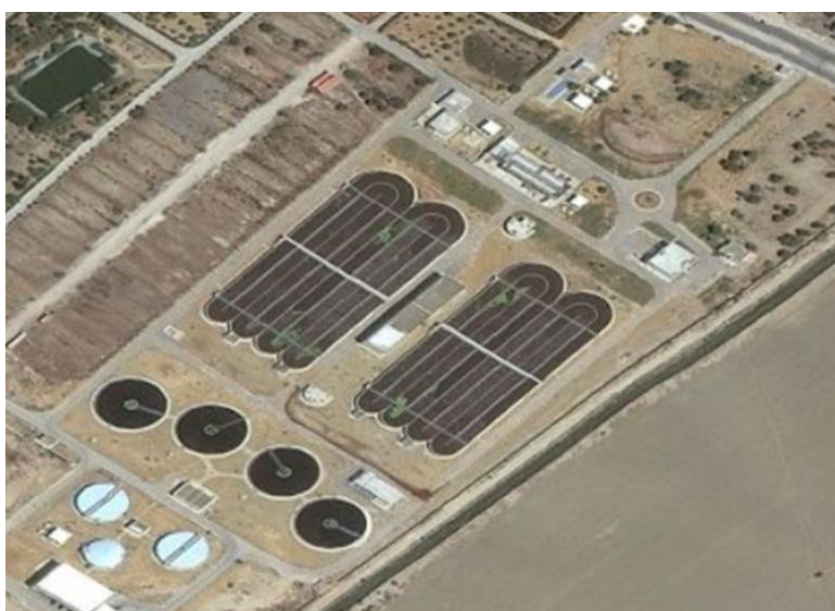
Figure 15 : Vue aérienne de la STEP de Choutrana 2
