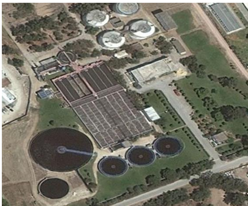
Figure 8 : Vue aérienne de la STEP de Cherguia (source : Google)
