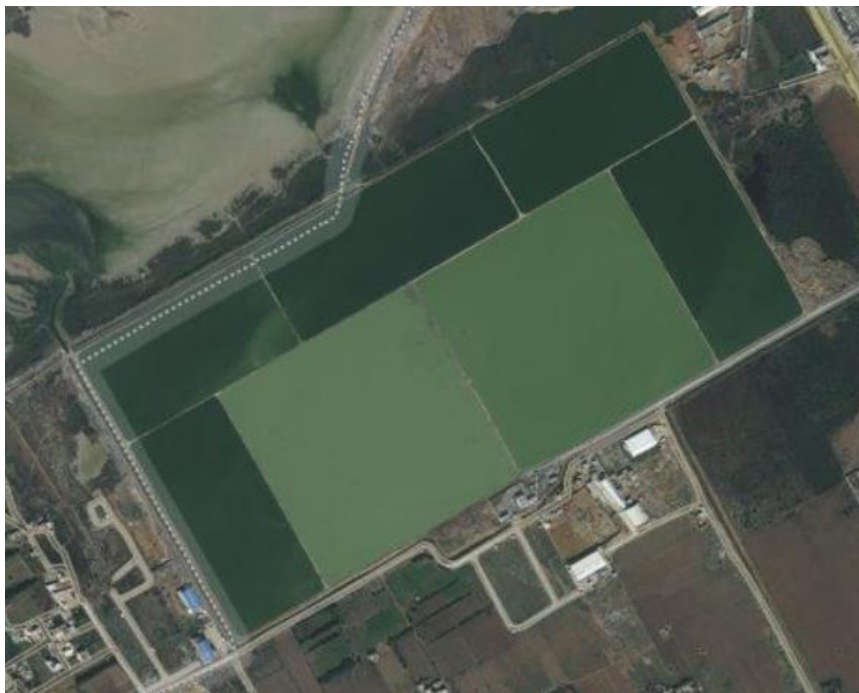
Figure 11 : Vue aérienne des lagunes de la STEP côtière Nord
