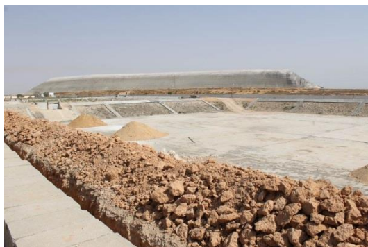
Figure 33 : bassin en arrêt pour réhabilitation
