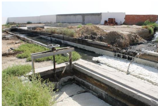
Figure 28 : Canal d'amenée des eaux brutes
