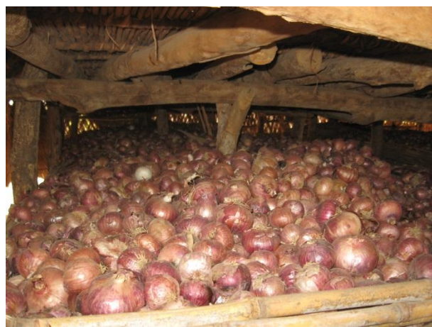
Photo 4 : Les traverses des claies sont renforcées par un poteau au centre.
