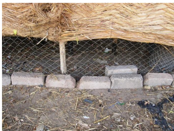
Photo 2 : Briques ou moellons placés dans le bas du treillis
