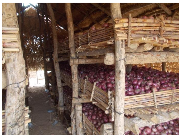
Photo 3: Vue d'une rangée de 3 claies de hauteur. La hauteur indiquée sur plan est sur le dessus des tiges de sorgho de la claie
