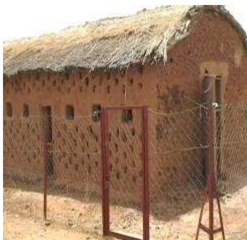
Photo 5 : Vues externes du magasin-abri à oignon de type ANPIP, installé à Guidan Iddar (Konni).
