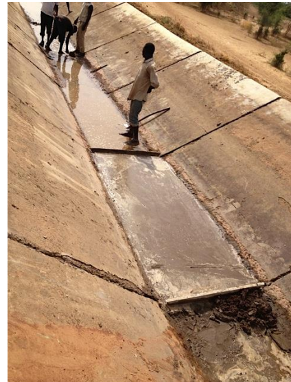
Figure 8 : travaux de réhabilitation de 200ha
