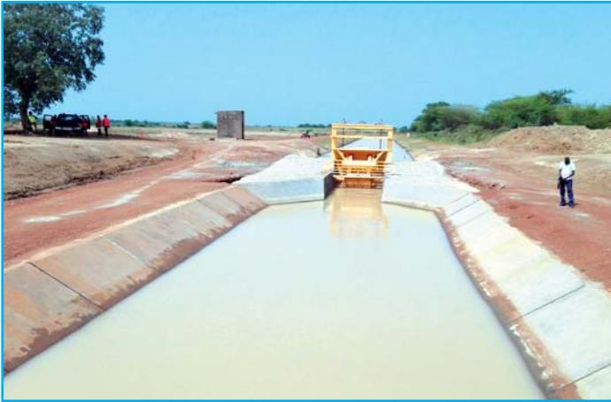
Mise en eau du canal primaire des 2582 ha en rive gauche du Nakanbé
