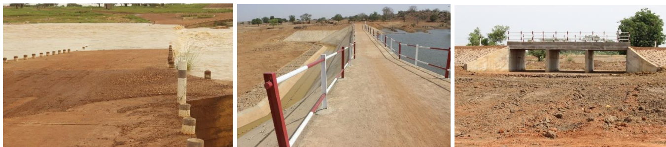
Le radier (à gauche) et des Ouvrages de franchissement à Lengha (au centre) et à Bega (à droite)
