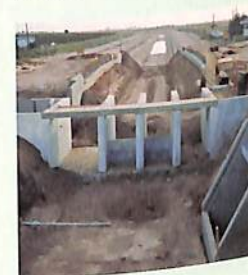
utilisation d'ouvrages préfabriqués
