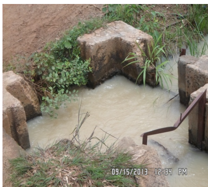
Destruction et vol de vannettes de prises TOR
