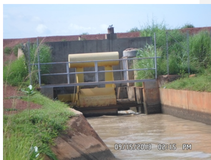
Absence de régulation aval vannes Avios bief B
