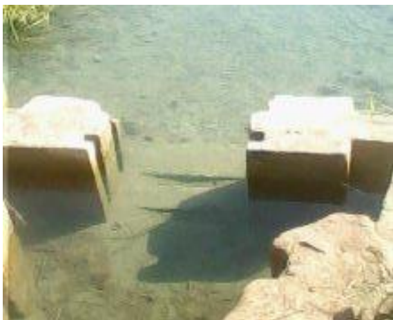
Digue de retenue projet PADERCA
