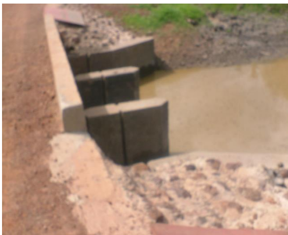
Digue de retenue projet PAPIL
