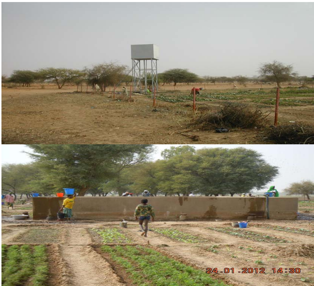
Photo n° 3 : Dispositif d'adduction d'eau dans le site maraîcher de Markoye
