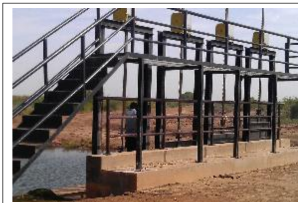
Photo 1 : Ouvrage de prise vannée sur le Gorom Aval
