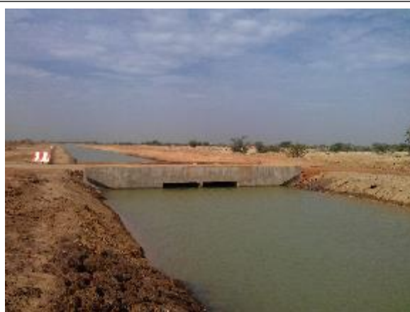
Photo 7 : Ouvrage sur adducteur
