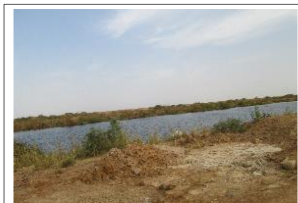
Photo 2 : Le Gorom Aval après travaux
