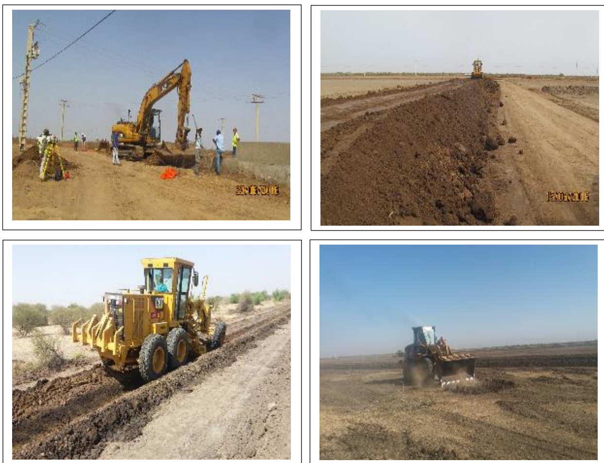
Photos 9, 10, 11, 12 : Chantier aménagement 1975 ha
