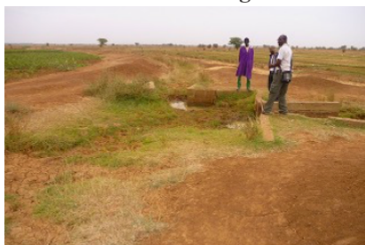
Faible contrôle de l'eau d'irrigation à cause d'une absence d'ouvrages de répartition.
