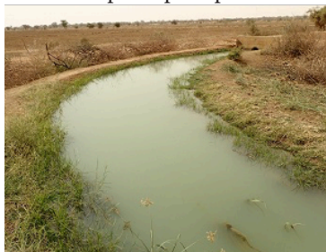
Courbure du canal principal Après
