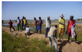
Marquage au piquet des points d'intervention
