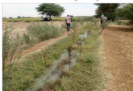
Section du canal principal Avant
