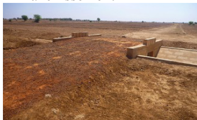
Le paddy peut être facilement évacué grâce à l'ouvrage de franchissement.
