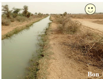
Canal principal Après
