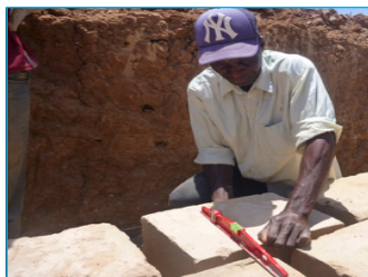
Nivelage des blocs de béton
