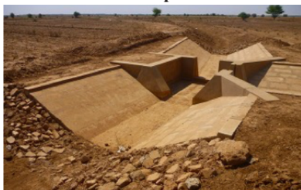
L'eau d'irrigation est contrôlée grâce au partiteur. La distribution de l'eau d'irrigation est régulée par un jeu de vannes.
