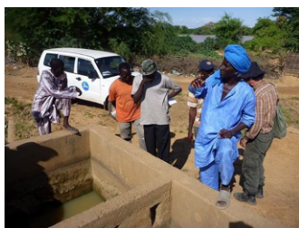
Discussions sur l'état du bassin de dissipation
