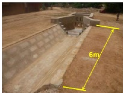
Image 7 : Revêtement en béton
