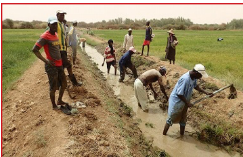
Nettoyage du canal principal
