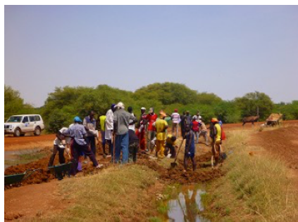
Réparation de brèche
