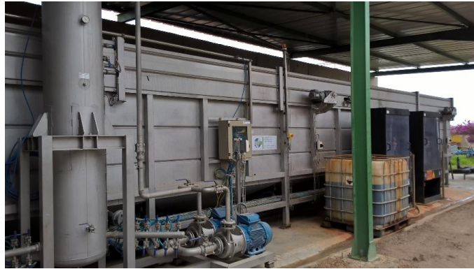
Figure 9 : Filtre presse du traitement des boues de VITALAIT
