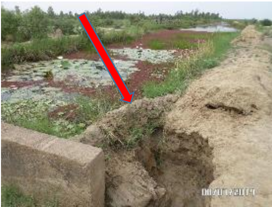
Figure 17 : Image du partiteur KLO, Moussa Wèrè ; Source : KOUAKOU et KOUMARE, visite de terrain 2014
