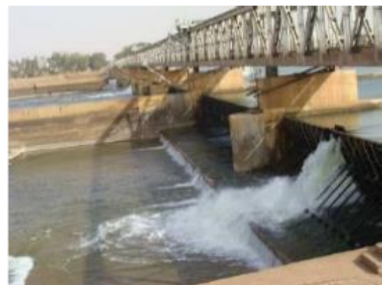
Figure 4 : Pont - barrage de Markala
