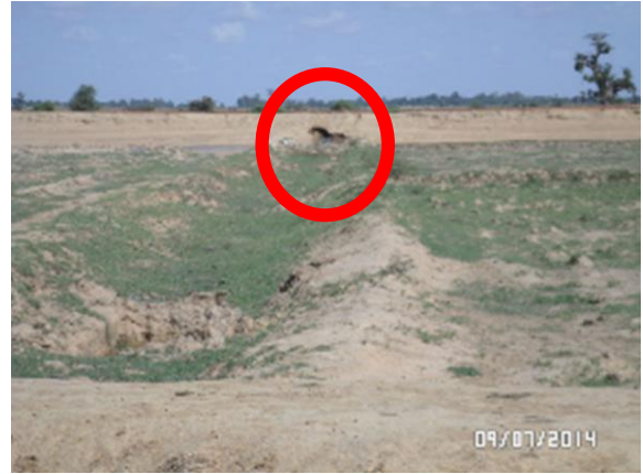
Figure 27 : Image montrant une brèche sur le distributeur Rétail IV ; Source : KOUAKOU et KOUMARE, visite de terrain 2014
