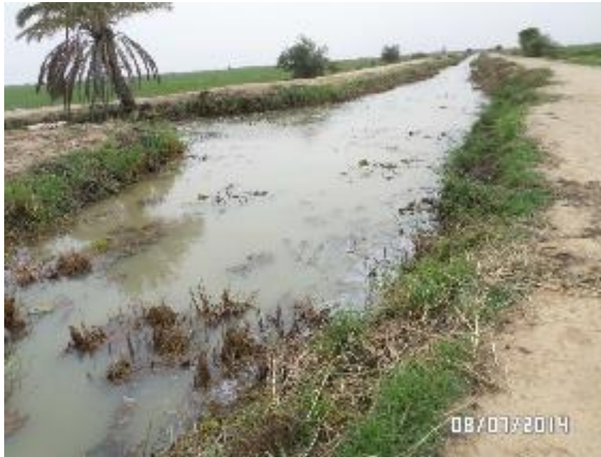
Figure 10 : Drain Sébougou à Moussa Wèrè ; Source : KOUAKOU et KOUMARE, visite de terrain, Juillet 2014
