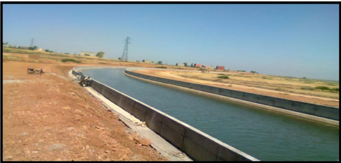
Figure 4: Surélévation du canal G
