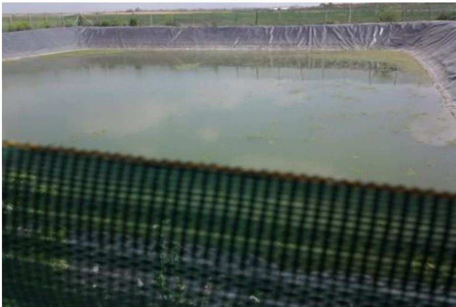
Photo 7 : Bassin de stockage (Merja Jouad-Tidjina)
