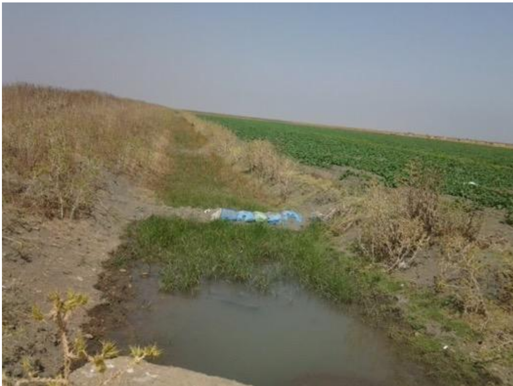
Photo 5: Interception des eaux de drainage par des batardeaux
