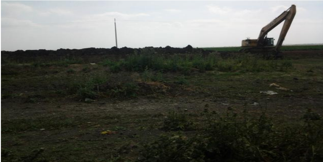
Photo 3 : Curage du canal R'dom et renforcement des digues
