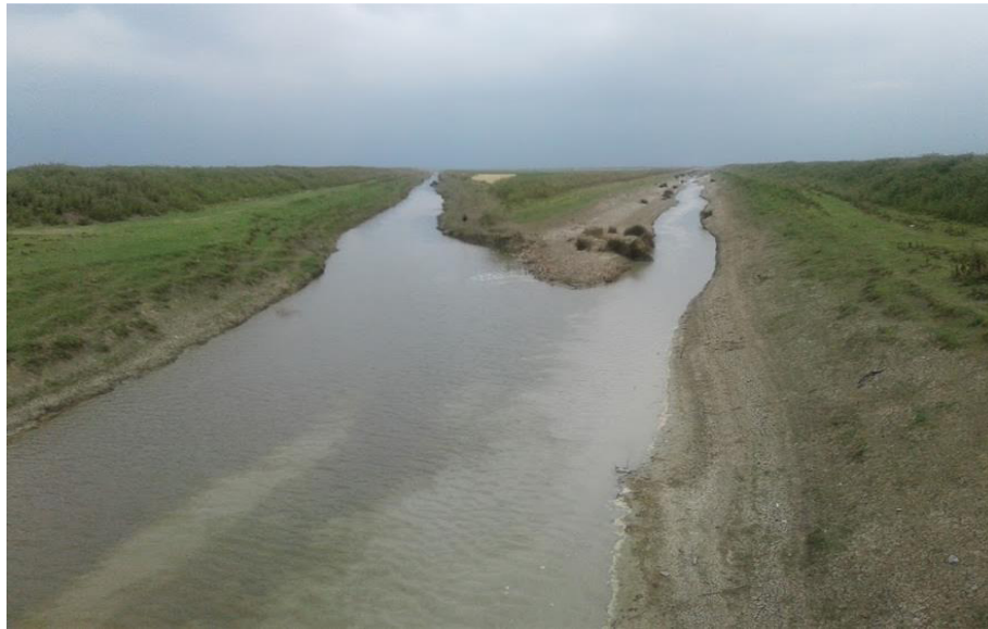
Photo n°5: Le canal Mda (à gauche) et le canal Madegh (à droite)
