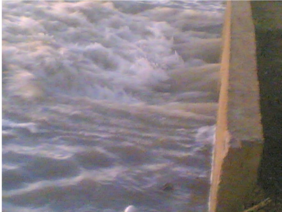
Photo n°6: Siphons en charge de la digue de Sidi El Hachemi El Bahraoui
