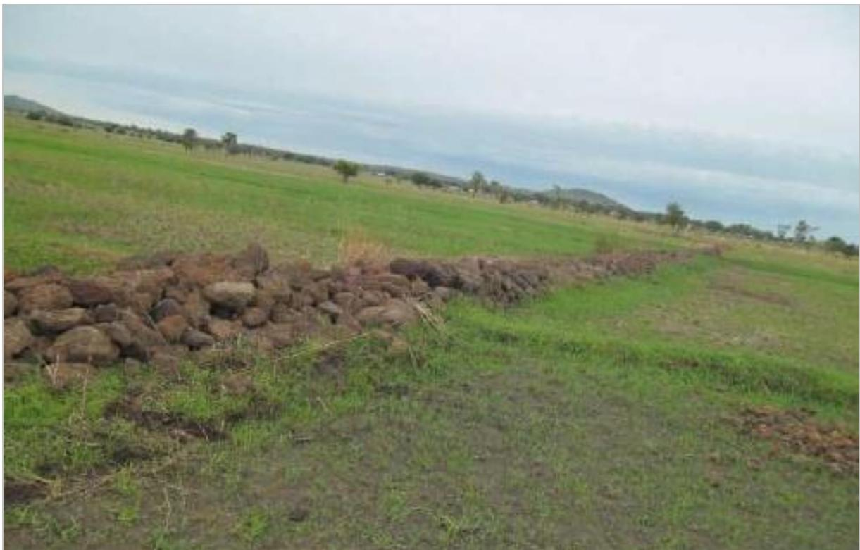
**Figure 11. Diguettes principales (Source: DGAT, 2013)**
