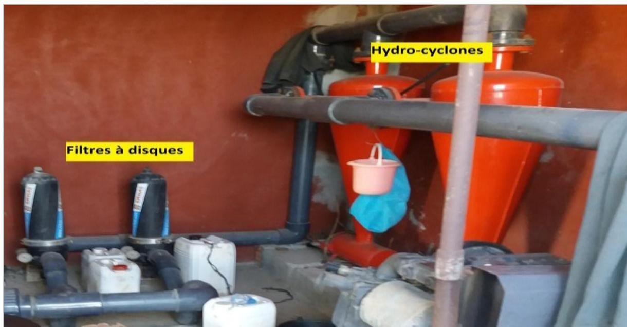
**Photo 12. Deux hydro-cyclones et deux filtres à disques assurant la filtration d'eau d'irrigation**
