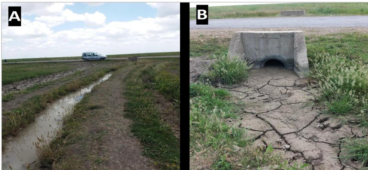
**Photo 6. 6-A. Un tronçon d'un réseau de canaux (seguias) utilisés comme adducteurs ; 6-B. Un dalot**
