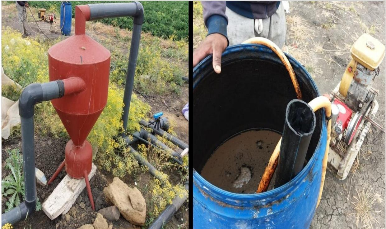
**Photo 9. Une station de tête composée d'un hydro-cyclone et un baril accompagné d'une pompe**
