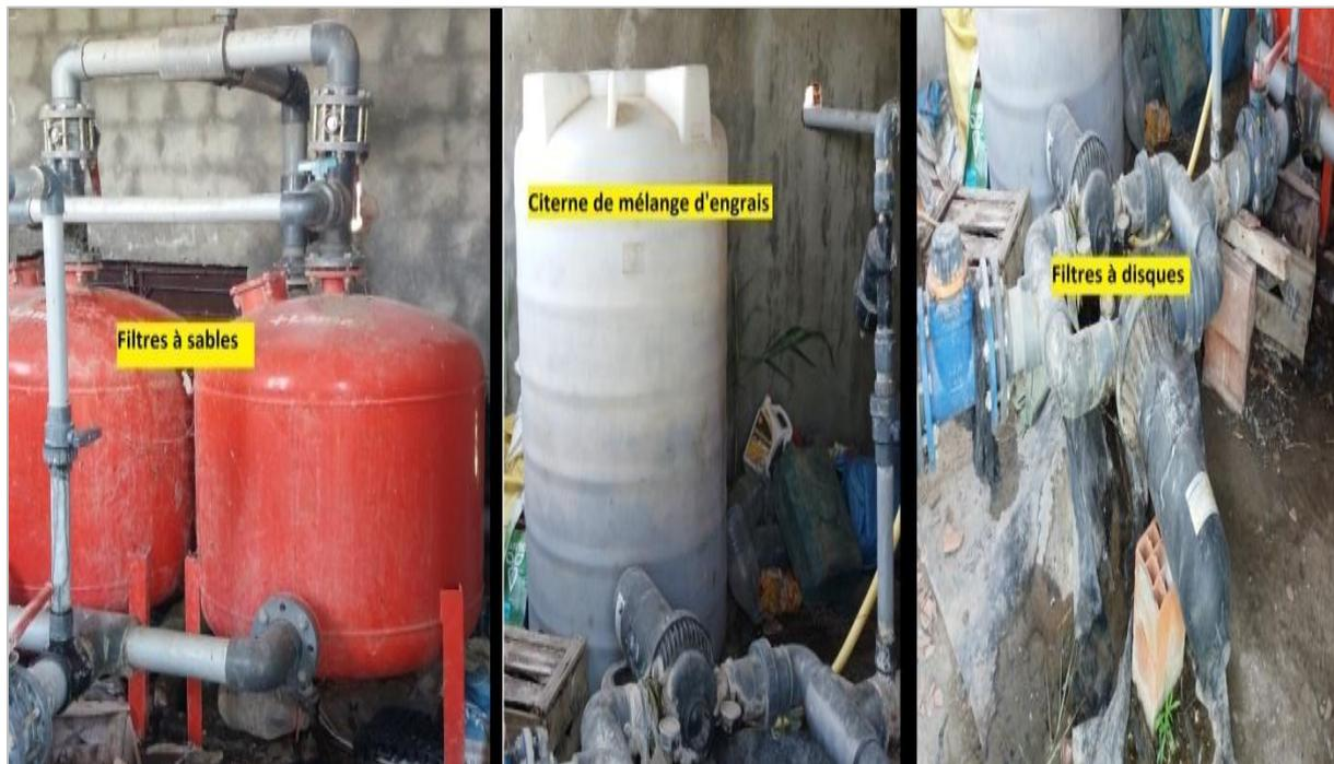
**Photo 11. Une station de tête au niveau d'une exploitation équipée en goutte-à-goutte**
