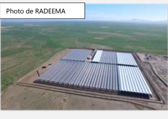
Illustration de la serre. Le retournement s'opère par un sanglier électrique (Electric pig), guidé à distance (Thermosystem Technologie)
