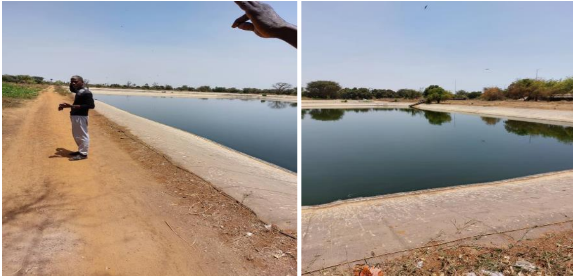
Photos : Vue sur les bassins de rétention des eaux usées traitées de la station de Thiès
