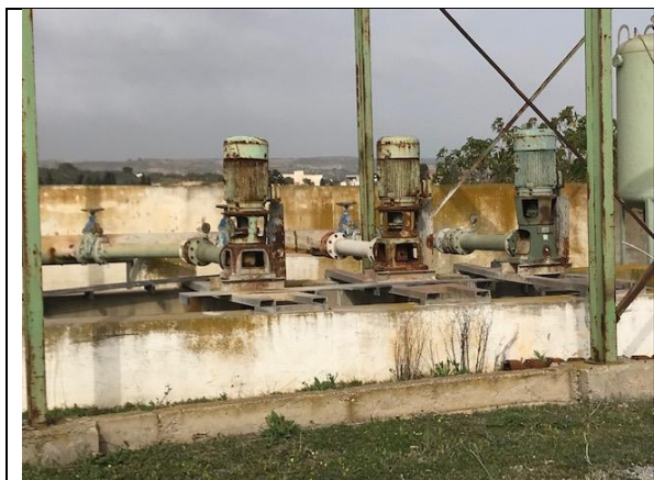
Figure 3 : Station de pompage SP4
