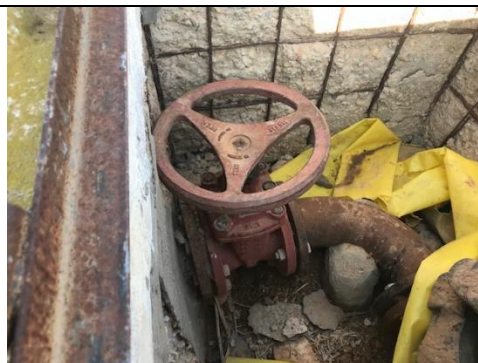
Figure 8 : Regard de vannage – El Hajeb
