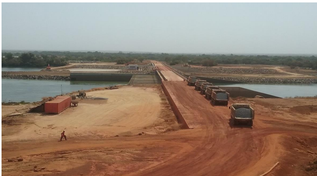
Photo 1: Vue d'ensemble du Seuil de Kourouba
