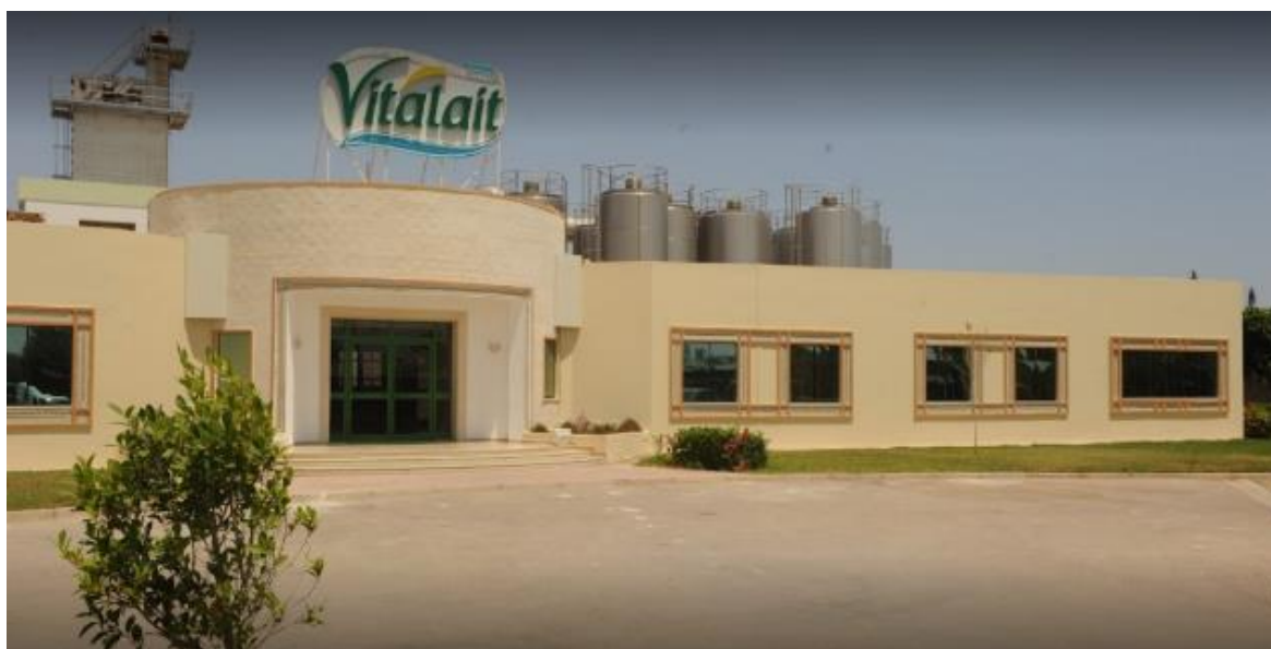
Figure 5 : Vue des bâtiments administratifs de la Centrale laitière Vitalait
