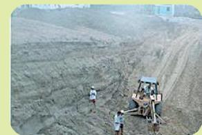
Barrage souterrain « de type brésilien » (avec film plastique)
