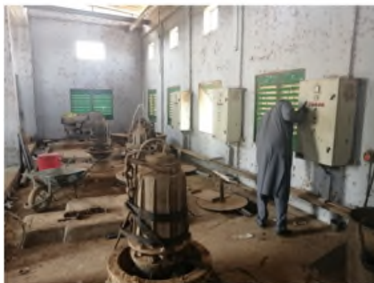
Vétusté des équipements de la station de pompage (périmètre de Saga, Niamey)
