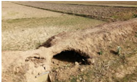
Dégradation d'une diguette entre une parcelle et un canal secondaire (périmètre de Daikaina, Tillabéri)
