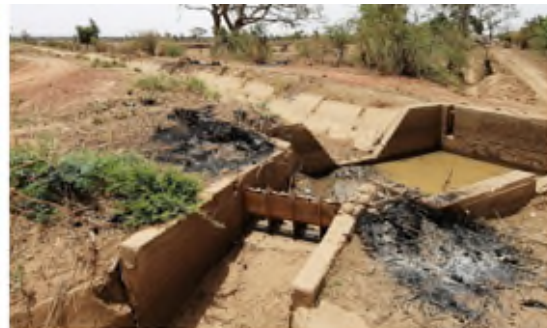
Etat de dégradation de canaux revêtus et modules à masques (périmètre de Saddia Amont, Niamey)
