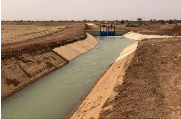
Ouvrage hydraulique, SAGI SAED, Vallée du fleuve Sénégal
