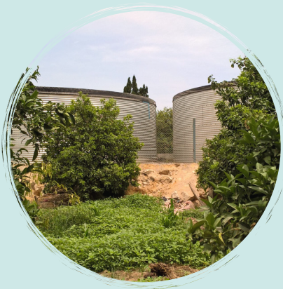
Oued Souhil à Nabeul (Tunisie), agrumes et cultures fourragères, avec réservoir de stockage des eaux usées traitées en arrière-plan
