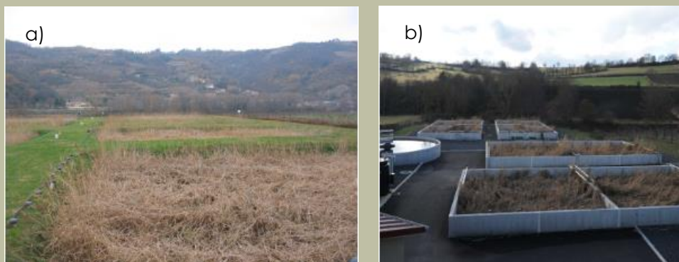
Figure 24. Configuration des LSPR, a) déblai-remblai b) casier béton
