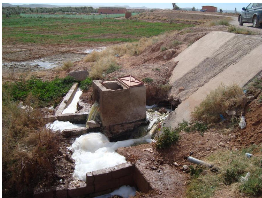
Figure 8: Prise d'eau existante à la sortie de la STEP
