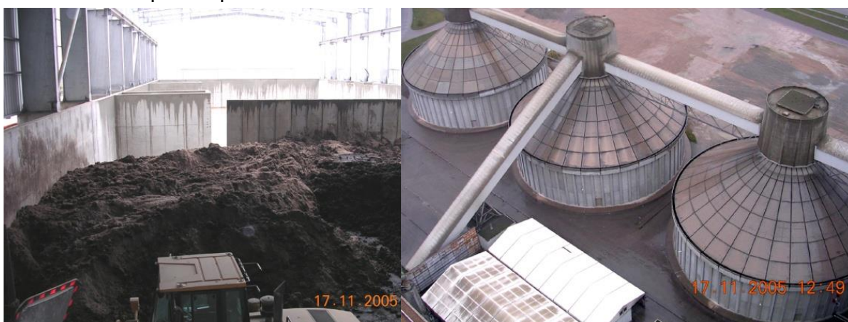
FIGURE 48 : CIMENTERIE BEERENBURG (ALLEMAGNE) : RESERVOIR DE BOUES DESHYDRATEES (A GAUCHE), RESERVOIR DES PIERRES PULVERISEES (A DROITE)
