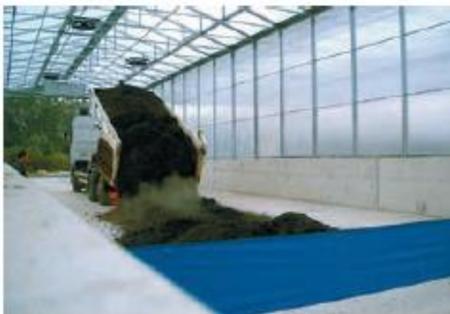
FIGURE 41 : REMPLISSAGE DES BOUES, AVEC LE CAMION (D'APRES LE FABRICANT (1))
