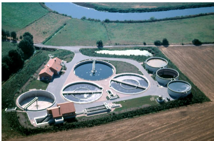
FIGURE 15 : STEP AVEC AERATION PROLONGEE, A DROITE 3 SILOS (RESERVOIRS DE BOUE POUR VALORISATION AGRICOLE)
