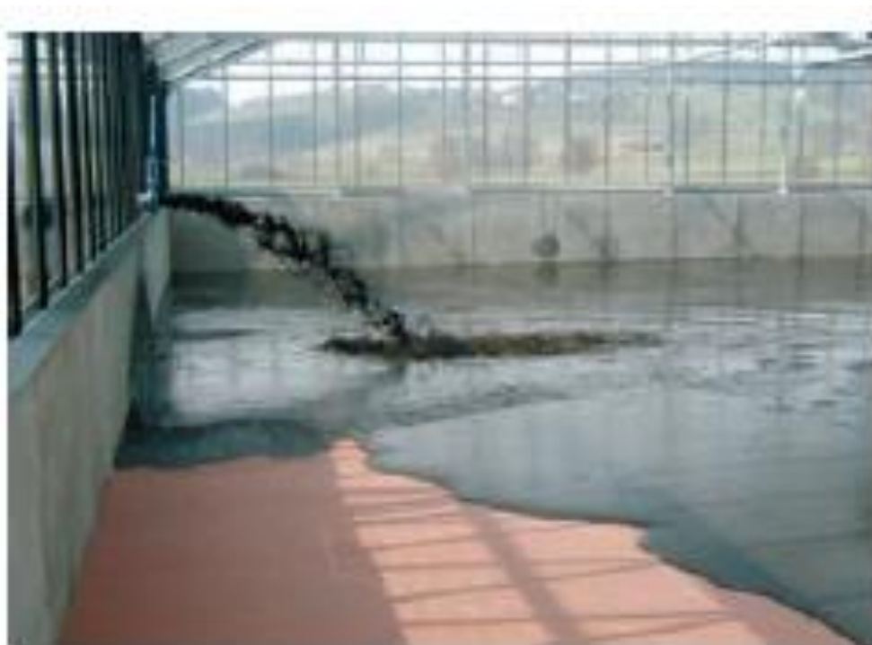
FIGURE 40 : REMPLISSAGE DES BOUES, AVEC DES POMPES (D'APRES LE FABRICANT (1))
