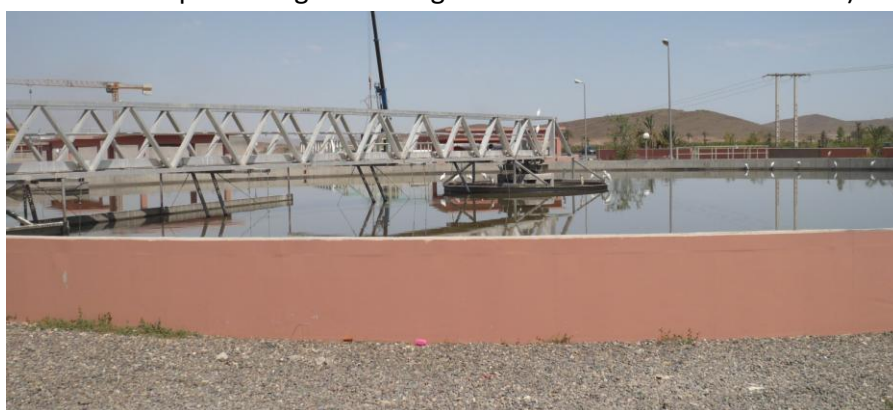
Figure 7 : Décanteur primaire
