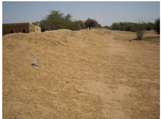
Etat actuel de la digue
