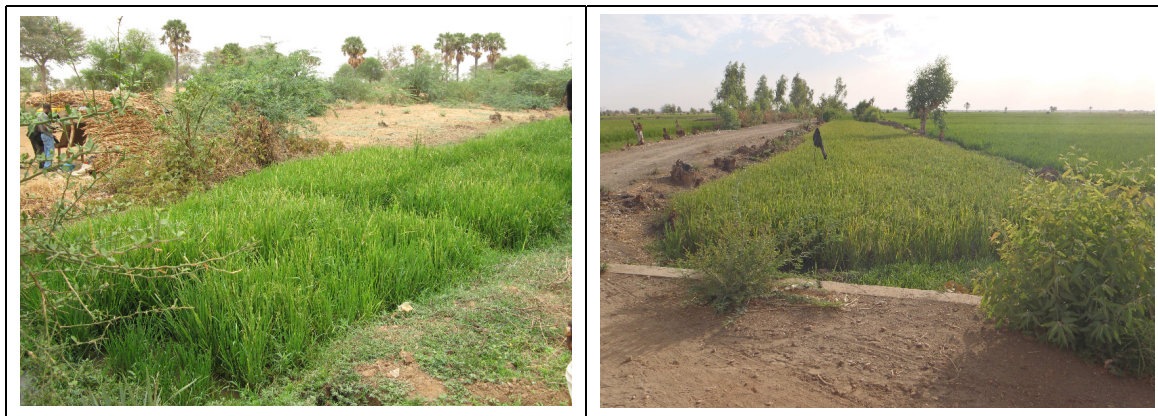
Photos 24 et 25 : Drains bouchés et cultivés (à Say et à Namarigoungou)
