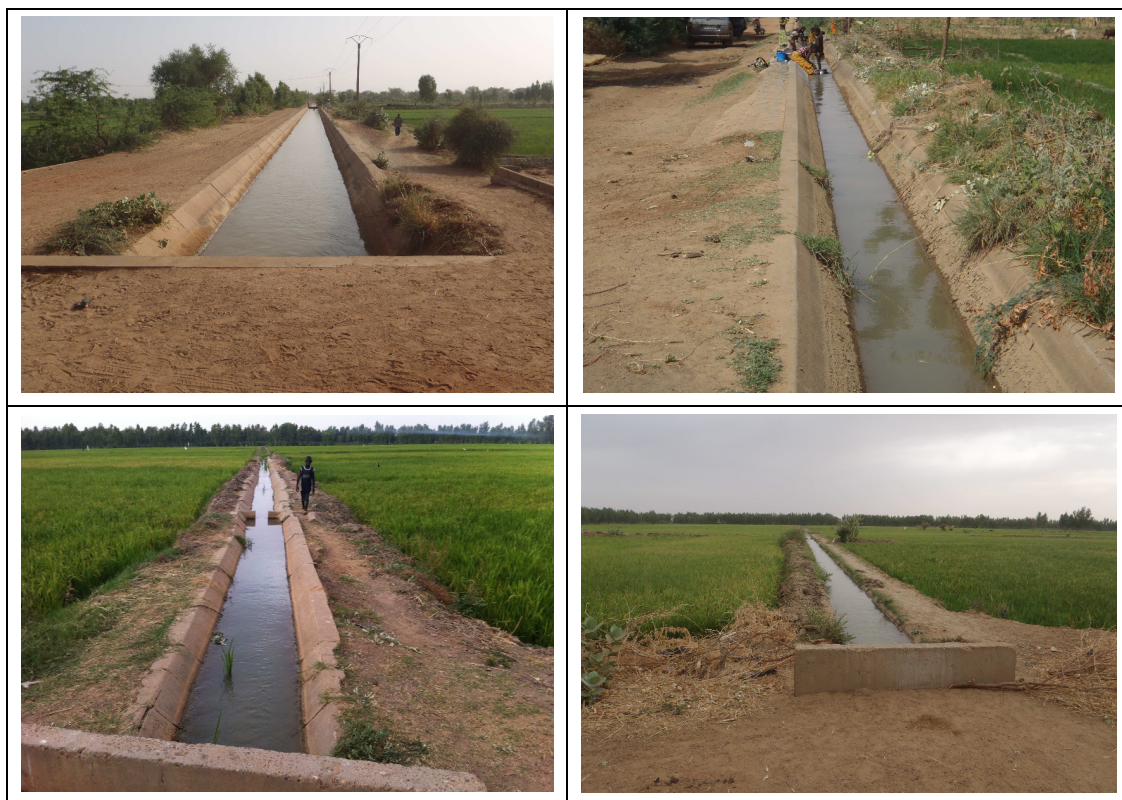
Photos 7 à 10 : Canaux primaires et secondaires à Lata, canaux tertiaires à Daïbéry
