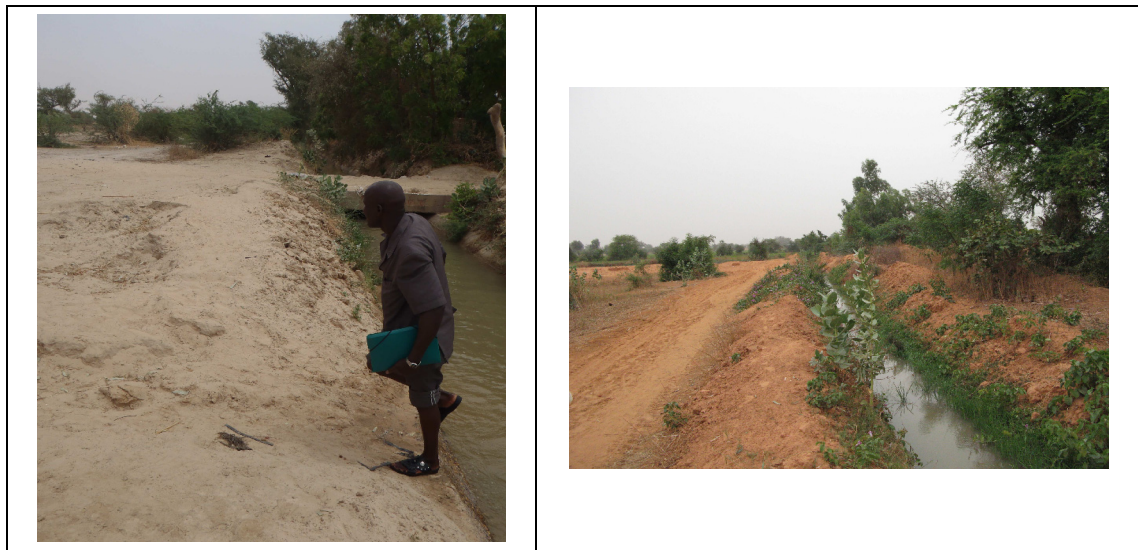
Photos 20 et 21 : Ensablement des canaux dans les PIP de N'Dounga 2 et de Say
