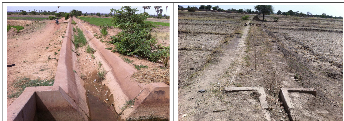
Photos 11 et 12 : Canal principal de Sakondji, vestiges du réseau à Kessa
