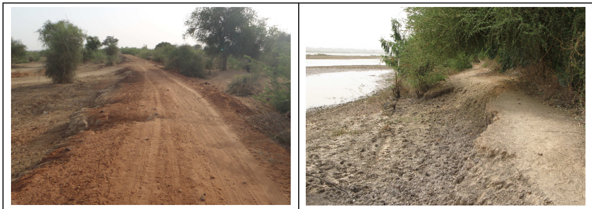
Photos 32 et 33 : Digue typique affaissée (cas de Daïkaïna) et l'impact de l'érosion du fleuve du la digue (Sébéry)
