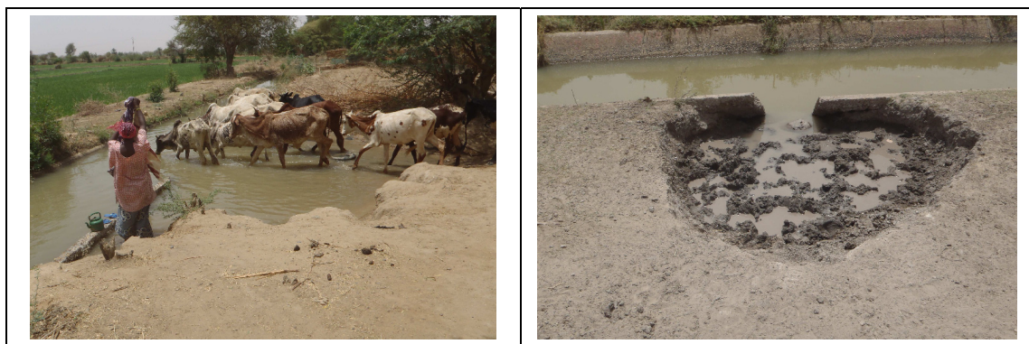
Photos 22 et 23 : Dégradation volontaire des réseaux de distribution d'eau
