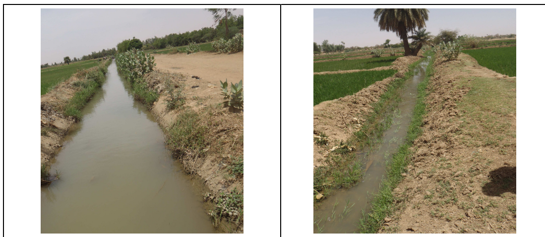
Photos 15 et 16 : Exemple de canal secondaire et tertiaire de N'Dounga 1
