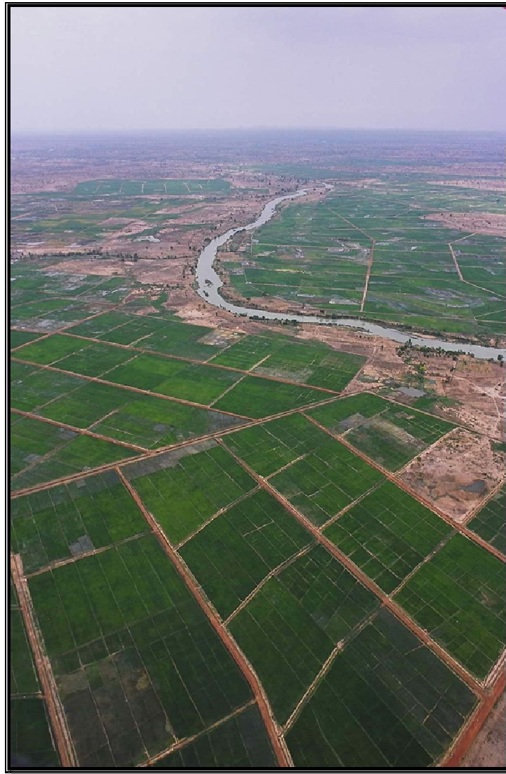
Figure 12 : Vue aérienne des aménagements rizicoles du périmètre de Bagré
