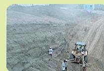
Barrage souterrain « de type brésilien » (avec film plastique)
