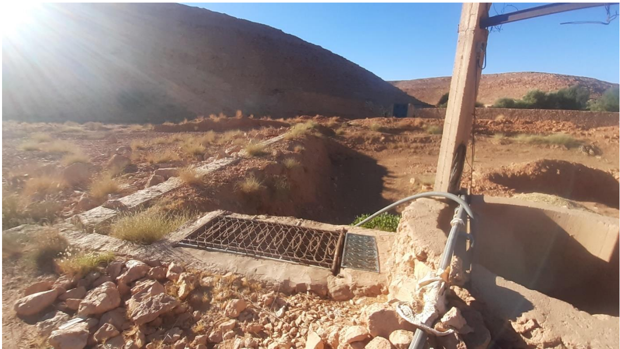
3- Diguette avec système de recharge de la nappe, Commune de Bounoura, Wilaya de Ghardaia, Algérie
