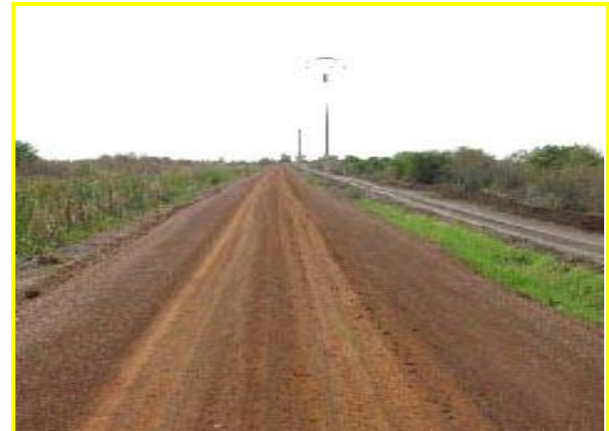
Piste après travaux du FoMIIG
