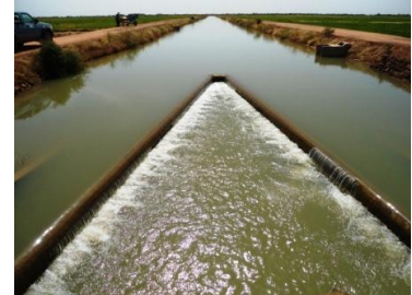
Déversoir en bec de canard
