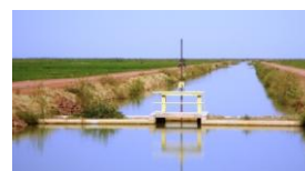
Vanne de sectionnement
