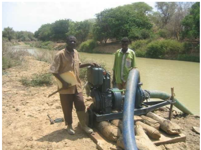
Figure 30 : Une vue de montage d'un groupe électropompe de surface sur socle constitué de béton et bois
