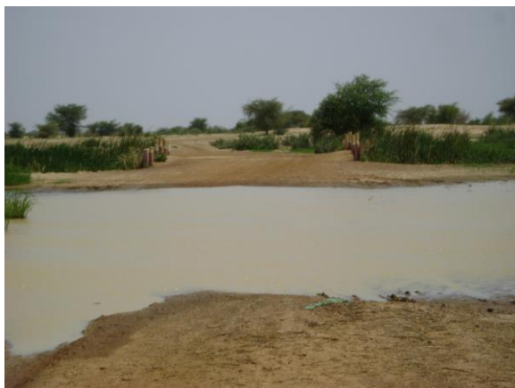
Piste avant travaux FoMIIG
