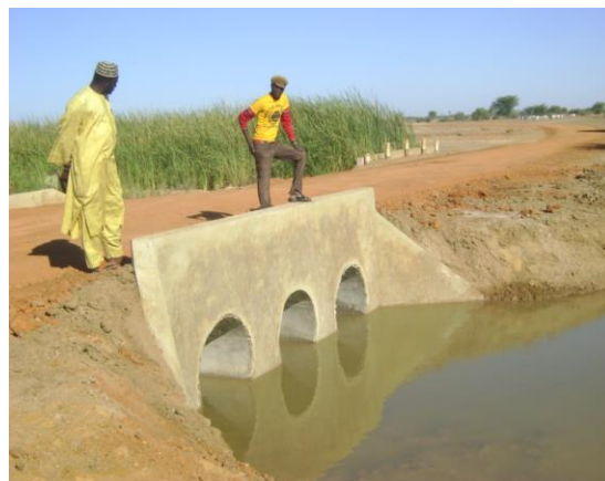
Piste après travaux FoMIIG
