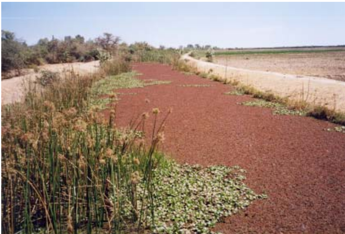
Photo 4 : mars 2002. Secteur N'Débougou. Les lentilles d'eau et les jacinthes d'eau prolifèrent dans le réseau de canaux de l'Office, à la faveur d'une teneur en nitrates en augmentation. Le risque à court terme est l'eutrophisation du milieu aquatique.
