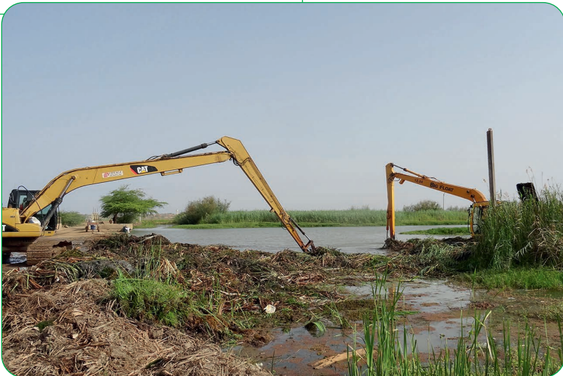
Photo 6.1. Curage mécanique d'un canal du périmètre du Lamptar, Sénégal © Jean-Yves Jamin, Cirad.
