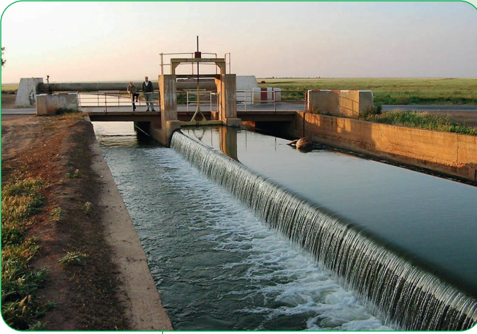
Photo 6.2. Ouvrage de régulation sur le Canal de Rocade, Office régional de Mise en Valeur du Haouz, Maroc © François Molle, IRD.
