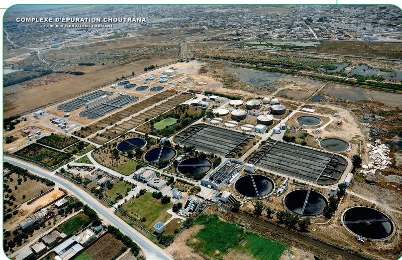
Photo 11.1. Vue de la station de traitement par boues activées de Choutrana, Tunisie
