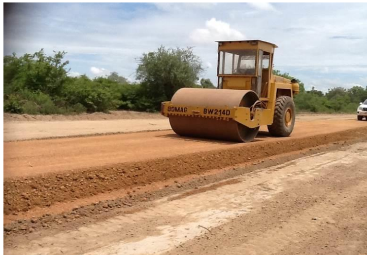
Vue des travaux dans le cadre du PADER-TKT
