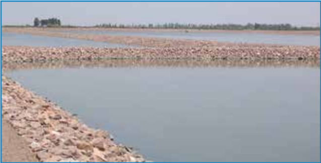
Lagunes de traitement Settat (Maroc) – Mayaux ICID 2015
