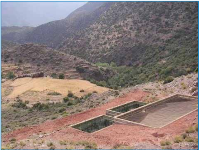
Projet de traitement des eaux usées par lagunage pour la réutilisation agricole à Tizi n'Oucheg (Haut Atlas – Maroc) - MediaVentures
