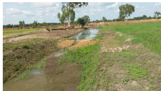
Figure 16 : Exemple de barrage en terre dans un drain tertiaire
