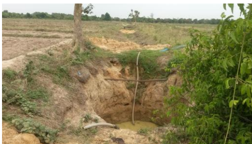
Figure 15: Exemple d'un puits dans le drain et le tas de terre déposé dans le drain
