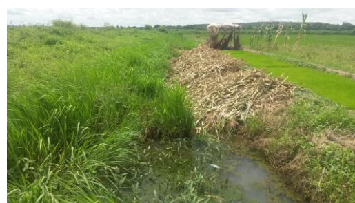
Figure 18: Remplissage de drains par les débris de maïs
