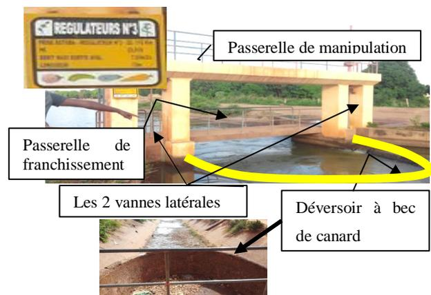
**Figure 14:** Régulateur N°03 du canal de Baguinéda
