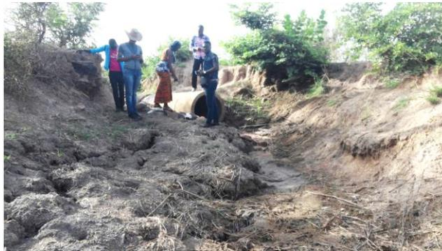
*Figure 15: Observation de l'état de dégradation d'un débouché de drain tertiaire sur le drain13a*
