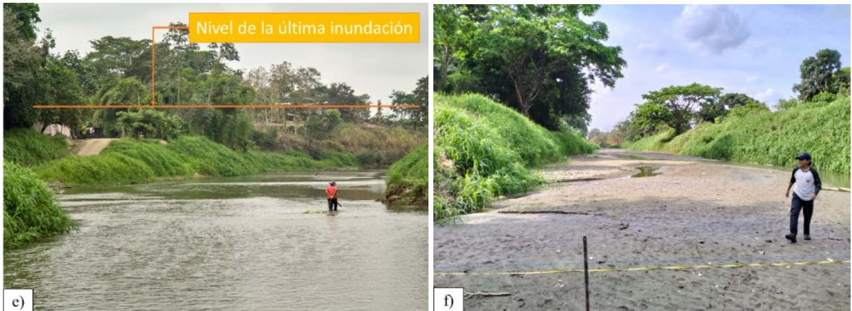
Figura 16. a) río Puca en el sector Las Lajas b) vista lateral del punto de salida de la microcuenca del río Puca, c) vista frontal del punto de salida de microcuenca del río Puca, d) señalamiento del máximo nivel alcanzado de la última inundación en el punto de salida, e) nivel de la última inundación, y f) disminución del caudal del río Puca en septiembre de 2022 para medir su perfil.
