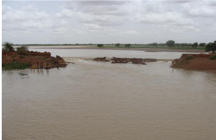
Figure 7 : Rupture de barrage de Toumour dans lors de la crue du 11 Juillet 2009. crédit : Catholic Relief Services.
