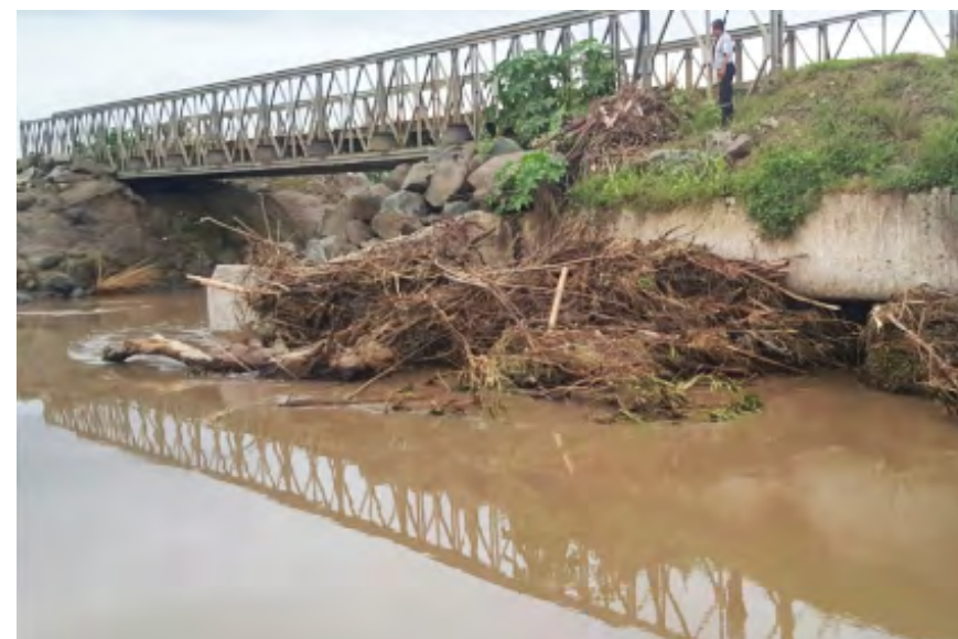
Foto 12: Puente provisional tipo Bailey del río Magro.
