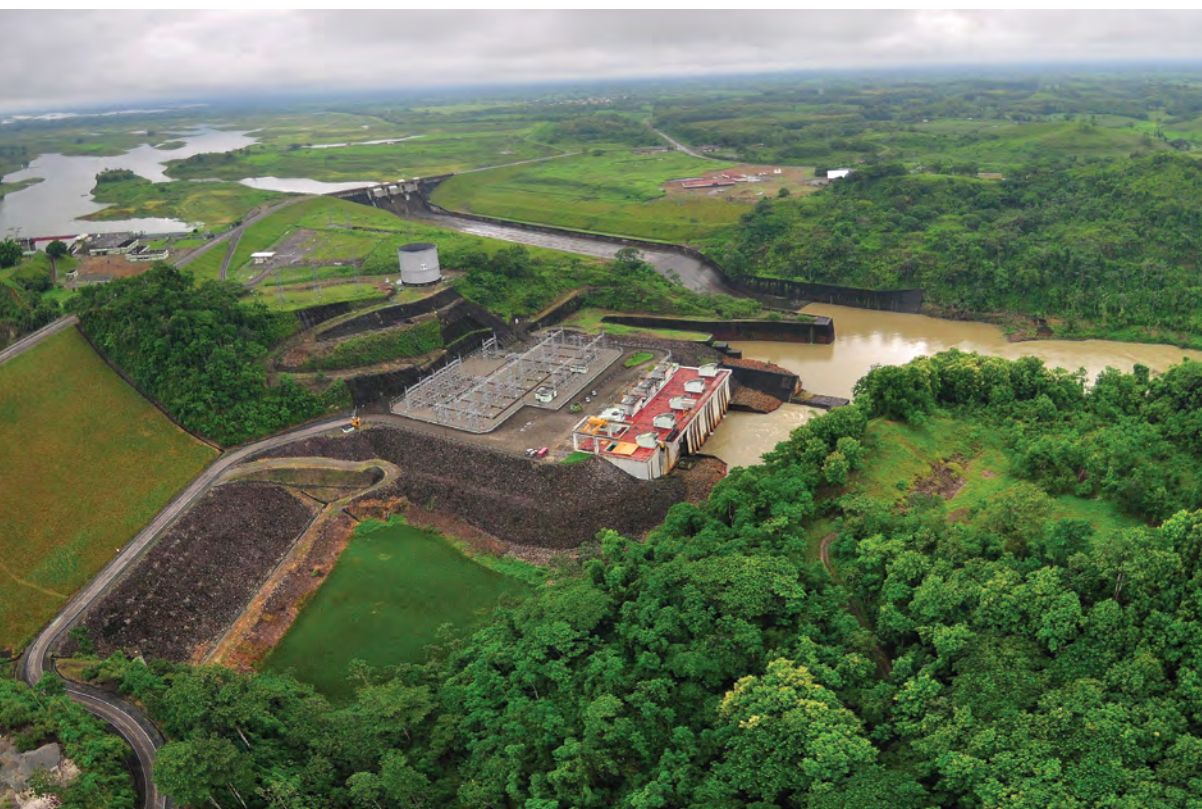
Foto 1: Represa Daule Peripa. Fuente: CELEP EP, 2016
