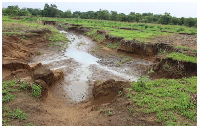
Figure 10 : Griffes de tête de ravine en amont du site du projet. Noter le départ de source à partir d'une couche plus tendre et drainante en dessous du bloc dur de surface (H.Kambire)
